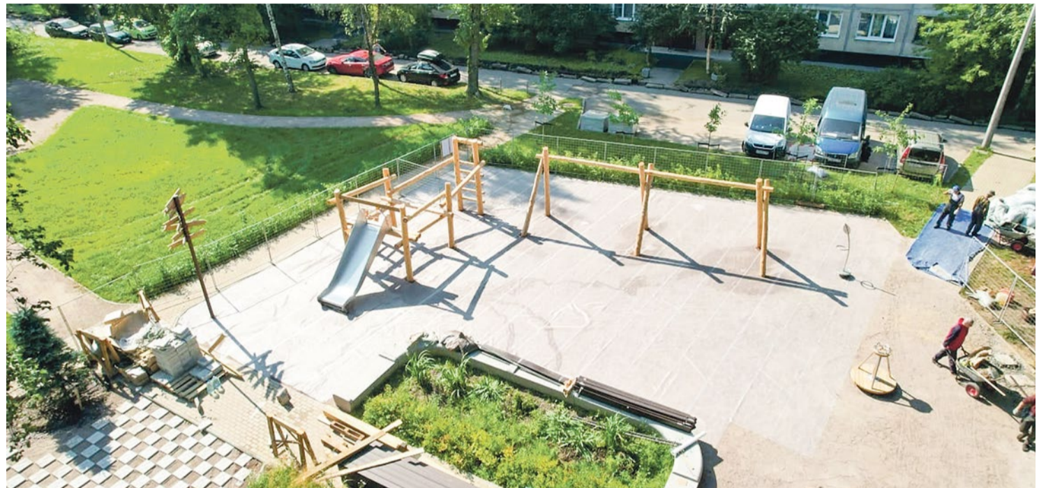
Строительные работы на Бухарестской улице, 86 подходят к концу
